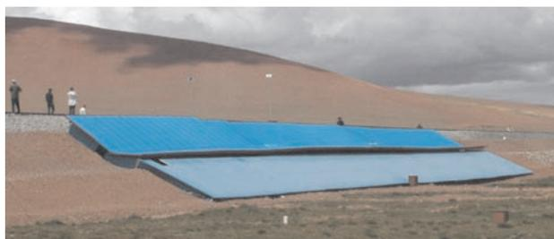
Рис. 5. Солнцезащитный навес на откосе насыпи Цинхай-Тибетской железной дороги на участке льдистых грунтов в основании (август 2006 г.)
